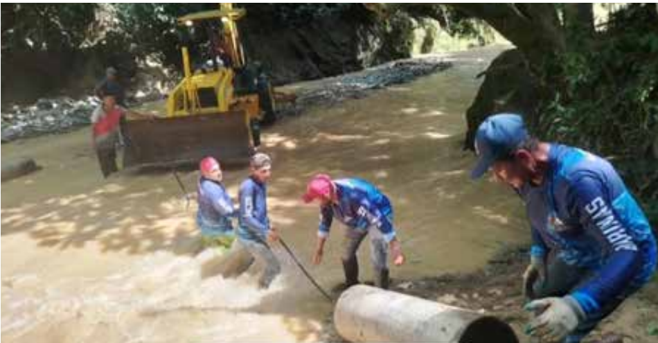
Avanzan trabajos para la recuperación de la tubería del acueducto de Socopó
