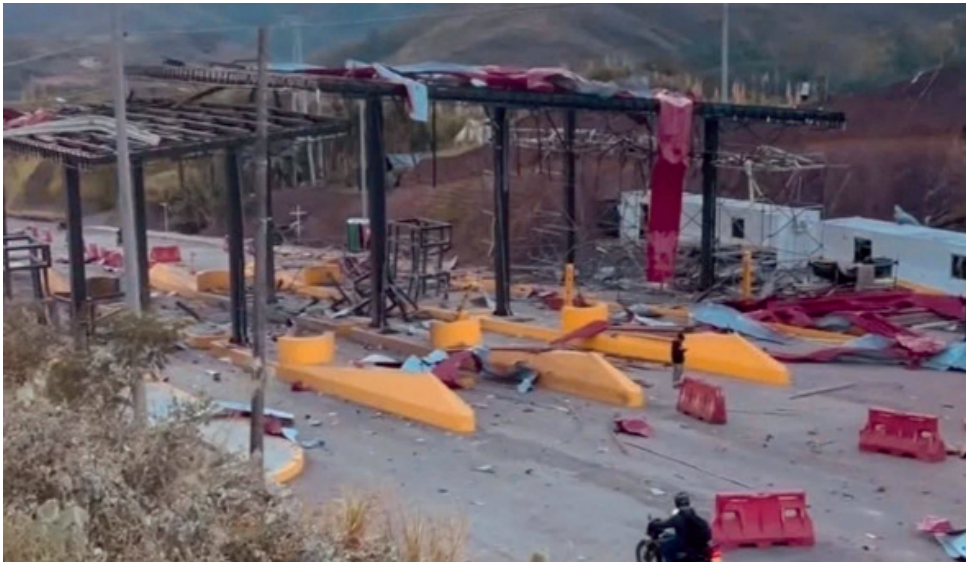
Como resultado de la explosión, el peaje quedó destruido y se restringió el paso por la Vía Panamericana, aunque no se informó de víctimas hasta el momento.
