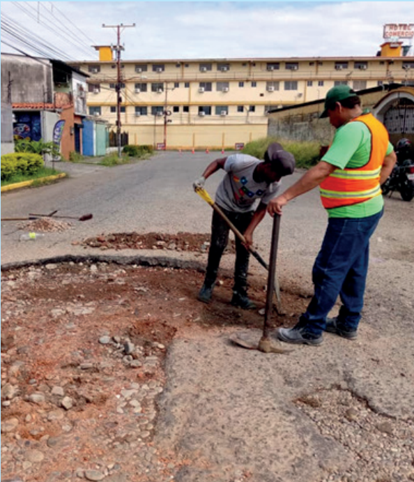
Reparación se cumplió en tronera de la avenida Sucre ( foto Neptali Querales)
