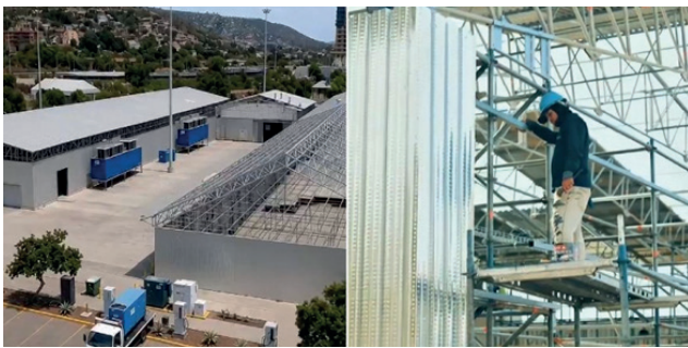
En paralelo, las autoridades ejecutan labores de rehabilitación y refuerzo en las estructuras permanentes del aeropuerto. (Foto LV)
