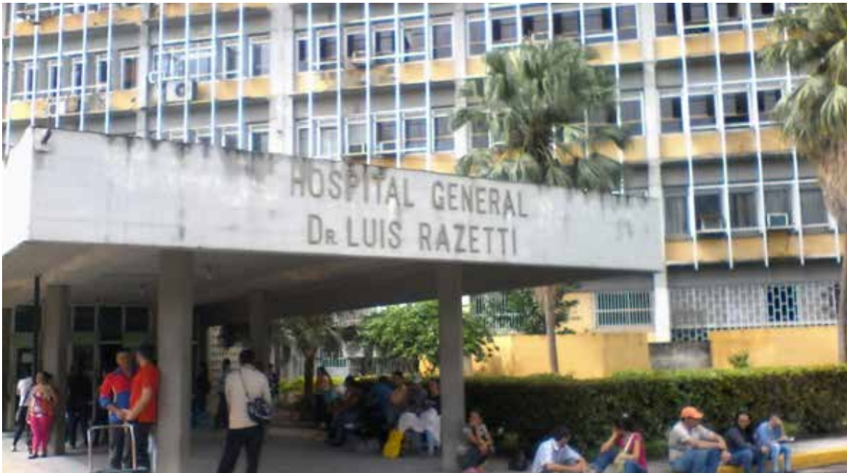
Fachada del Hospital Dr. Luis Razetti, dicha institución atraviesa una situación crítica debido a la inoperatividad de los equipos de aire acondicionado.
