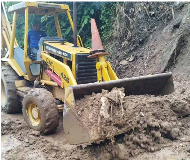
Gobernación de Barinas y alcaldía de Barinas adelantan trabajos de dragado en el río Santo Domingo, en el sector La Barinesa.
