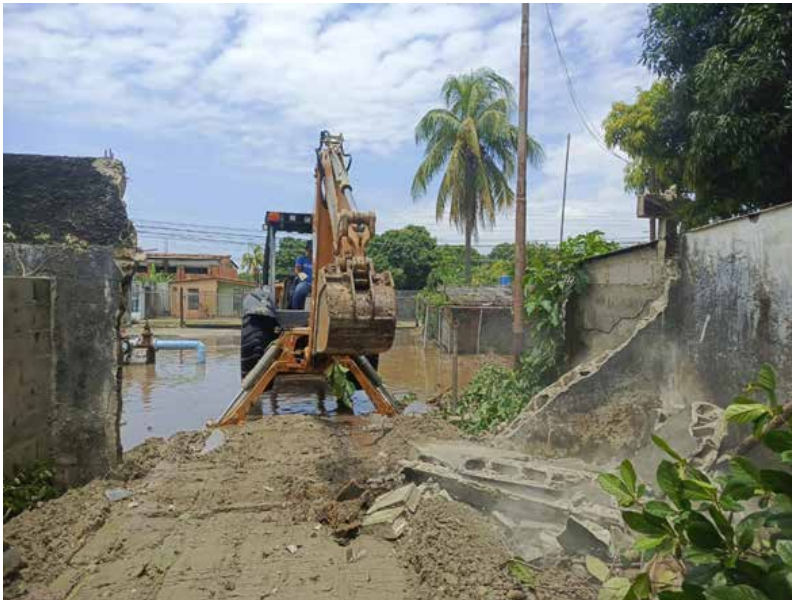
En el sector Los Próceres se ejecutaron labores para la reparación del tubo matriz que se reventó.
