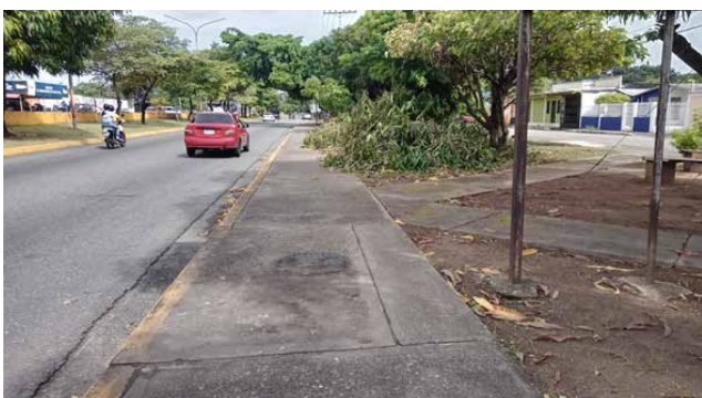
Cuadrillas podan árboles y dejan escombros o desmalezamiento sobre las aceras
