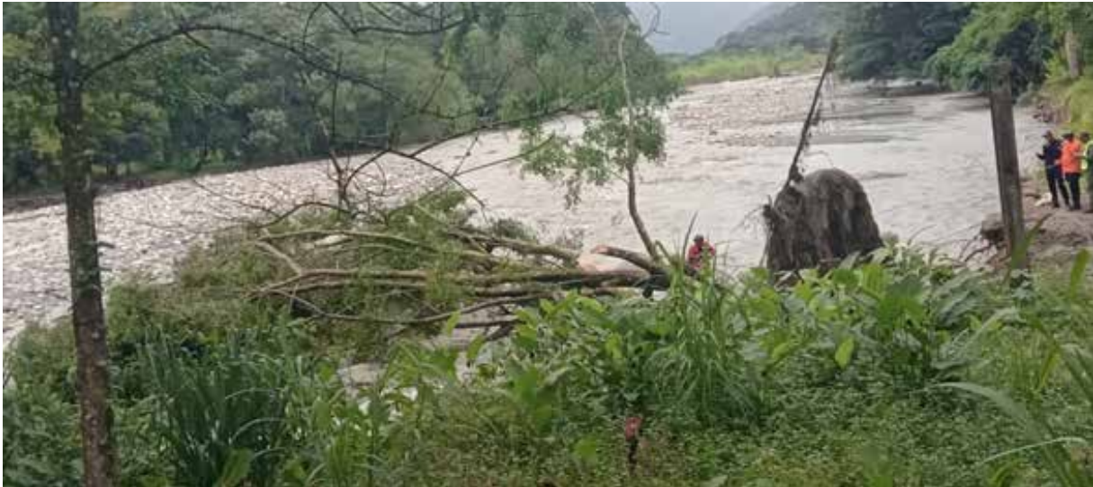
Mantenimiento piden para el puente La Barinesa.
