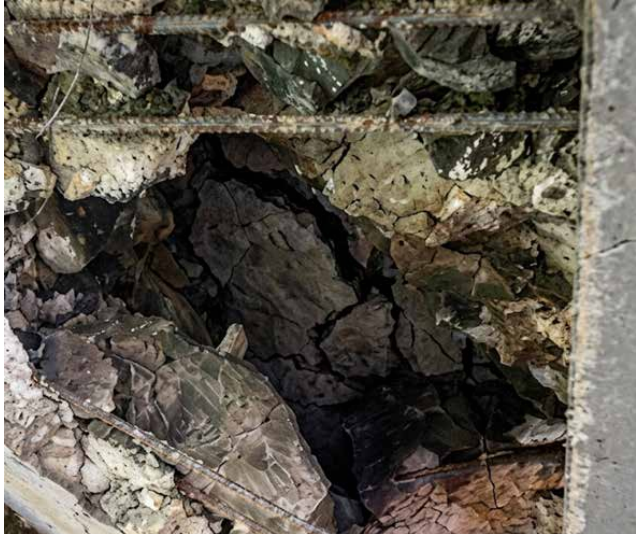
Imágenes estremecedoras revelan la base de la estructura totalmente socavada y las cabillas expuestas, mientras el tráfico pesado continúa pasando por encima.
