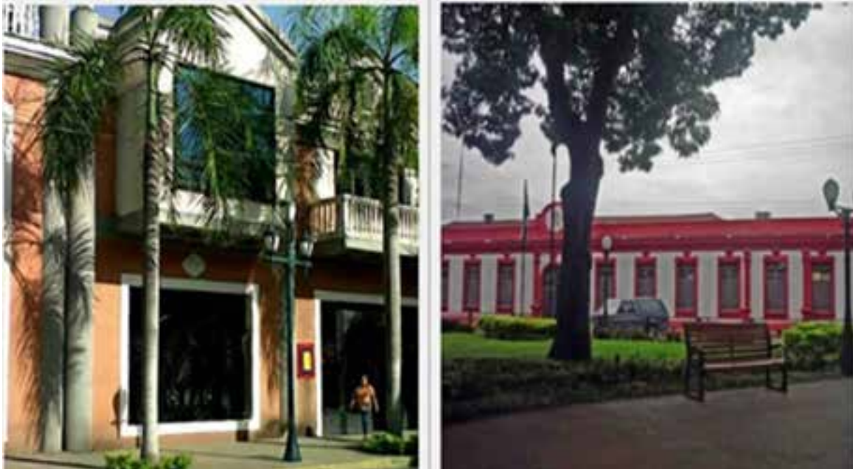
Gobernación y Alcaldía de Barinas a media máquina a causa de las fallas eléctricas...
