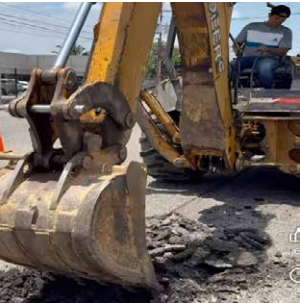
Se colocaron 30 toneladas de asfalto en la avenida Raúl Blonval López hasta la avenida Adonay Parra Jiménez. (Foto RAG)
