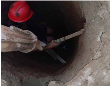
Un llamado a ingeniería municipal para que se pronuncie sobre esa obra ilegal y si concedió el permiso.
