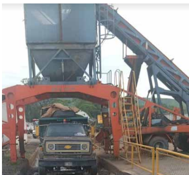
Corsobain e Intravial. adelantan trabajos para colocación de asfalto en la falla de Quiú en la T005 en Socopó
