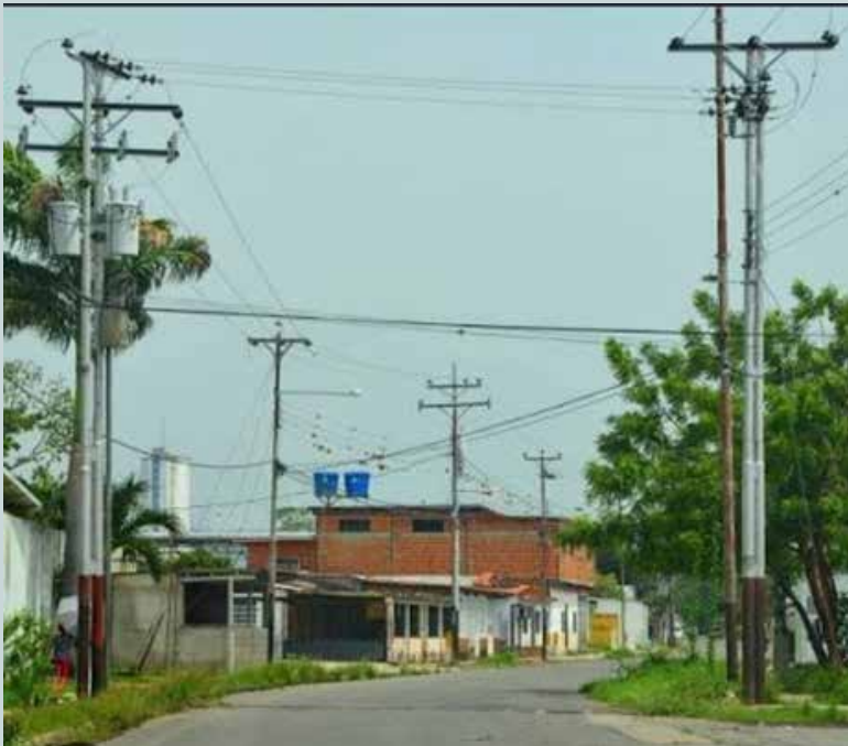
Fallas de agua continúa en ciertas comunidades de Barinas
