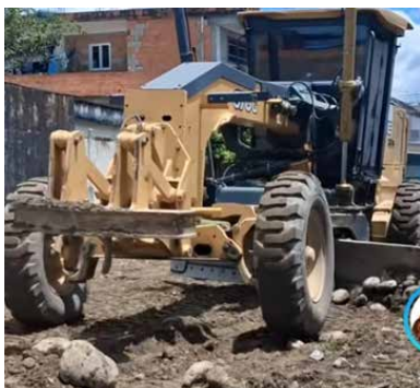
También siguen marcha labores para la rehabilitación de la vialidad urbana
