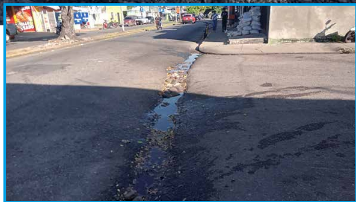
Las gráficas muestran condiciones de arterias viales y relleno de piedras y desechos de construcción para cubrir las zanjas.
