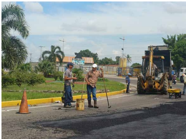
Labores de bacheo se cumplen en la redoma Industrial.
