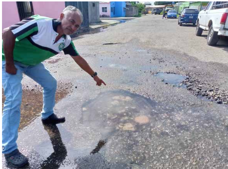
Reparación piden en la Nicolás Briceño ( foto Neptali Querales)
