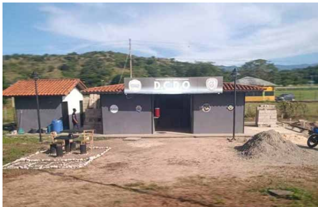
Los funcionarios están instalados de manera irregular en el parque biosaludable.
