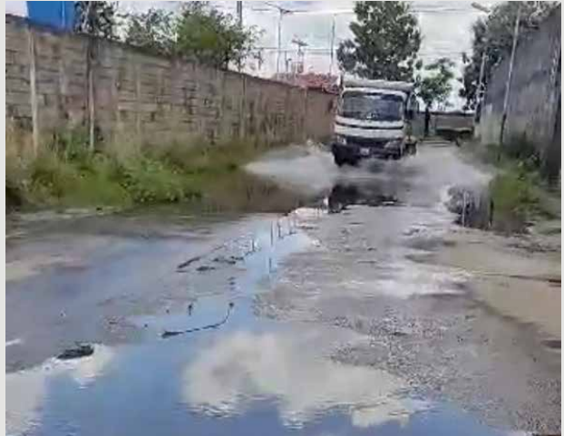
Aguas corren en las calles del Continental ( foto Neptali Querales)
