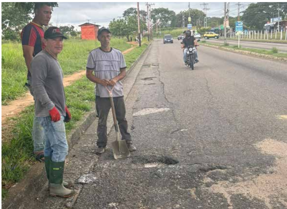
Vecinos se unen para levantar un reductor de velocidad, porque recalcan que a menos de 300 metros se encuentra una zona escolar...
