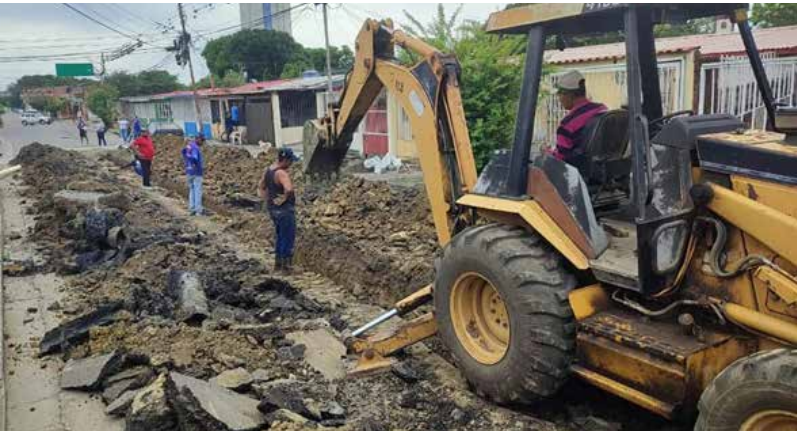
Adelantando trabajos de colector en Los Pozones ( foto D.P)
