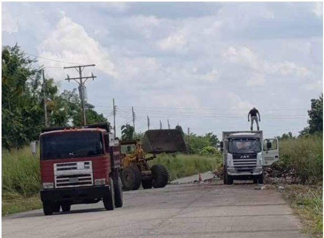
Maquinarias y cuadrillas cumplen la labor ( foto Neptali Querales)
