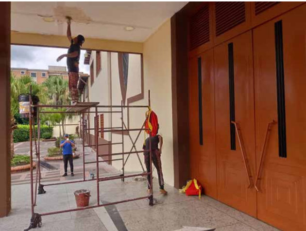
Trabajos en la iglesia y su plazoleta (foto Neptali Querales)
