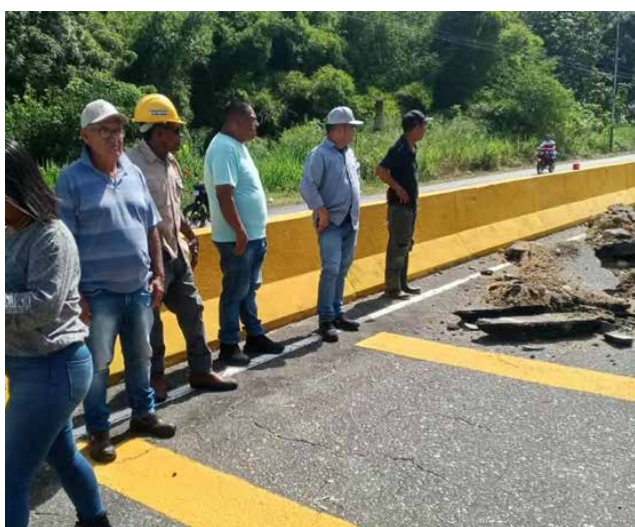
Equipos de trabajo cumplen labores de recuperación vial ( foto Neptali Querales)
