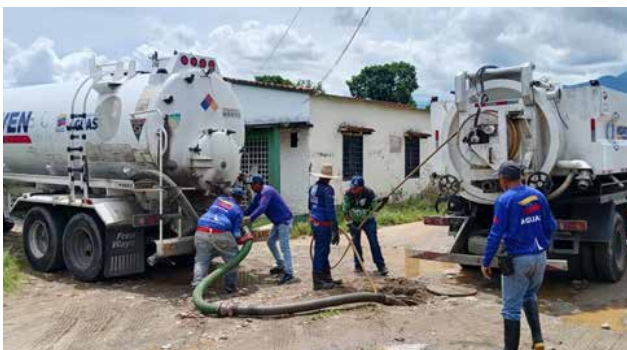
Servicios Públicos de Sucre mantiene limpieza de colectores
