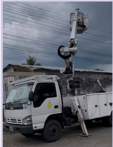
Trabajadores de CORPOELEC realizar recuperación del sistema eléctrico.
