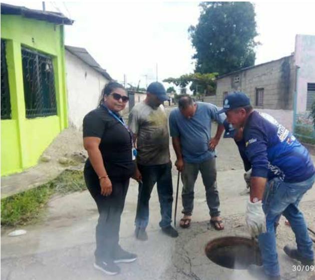
En las gráficas se observan a funcionarios de Hidroven realizando los trabajos de mantenimiento en la comunidad de Esperanza I.
