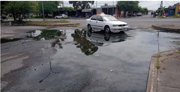
En la calle 22 de la urbanización Dominga Ortiz de Páez se estancan las aguas negras
