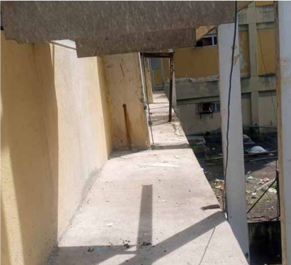
Labores de limpieza y mantenimiento se cumple en el Hospital Razetti ( foto Neptali Querales)
