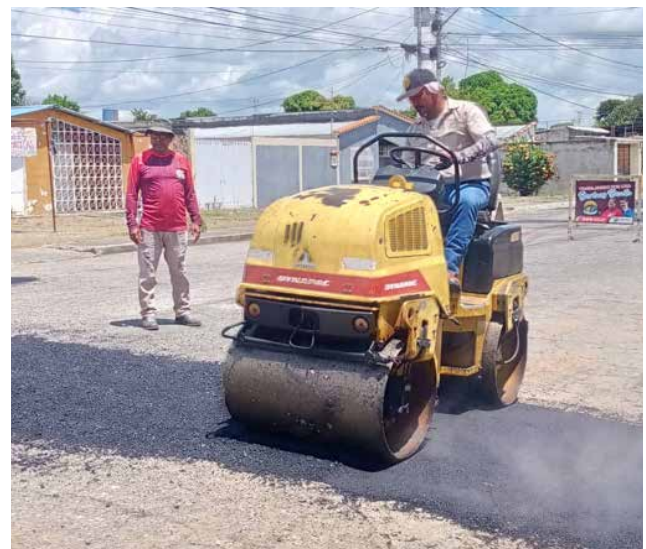
Bacheo se cumple en la Francisco de Miranda (foto Neptali Querales)
